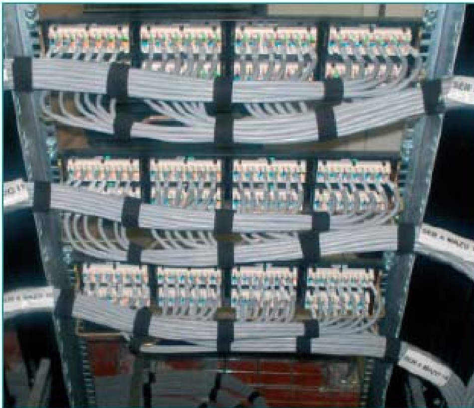
图 4.7 安装配线架组
