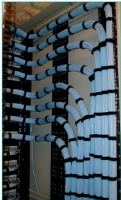
图 4.8 敷设并捆绑大量水平电缆
